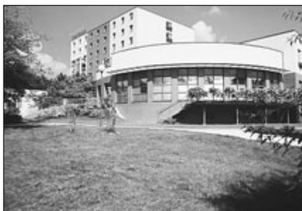
Vodoléčebný pavilon Jindřich.
